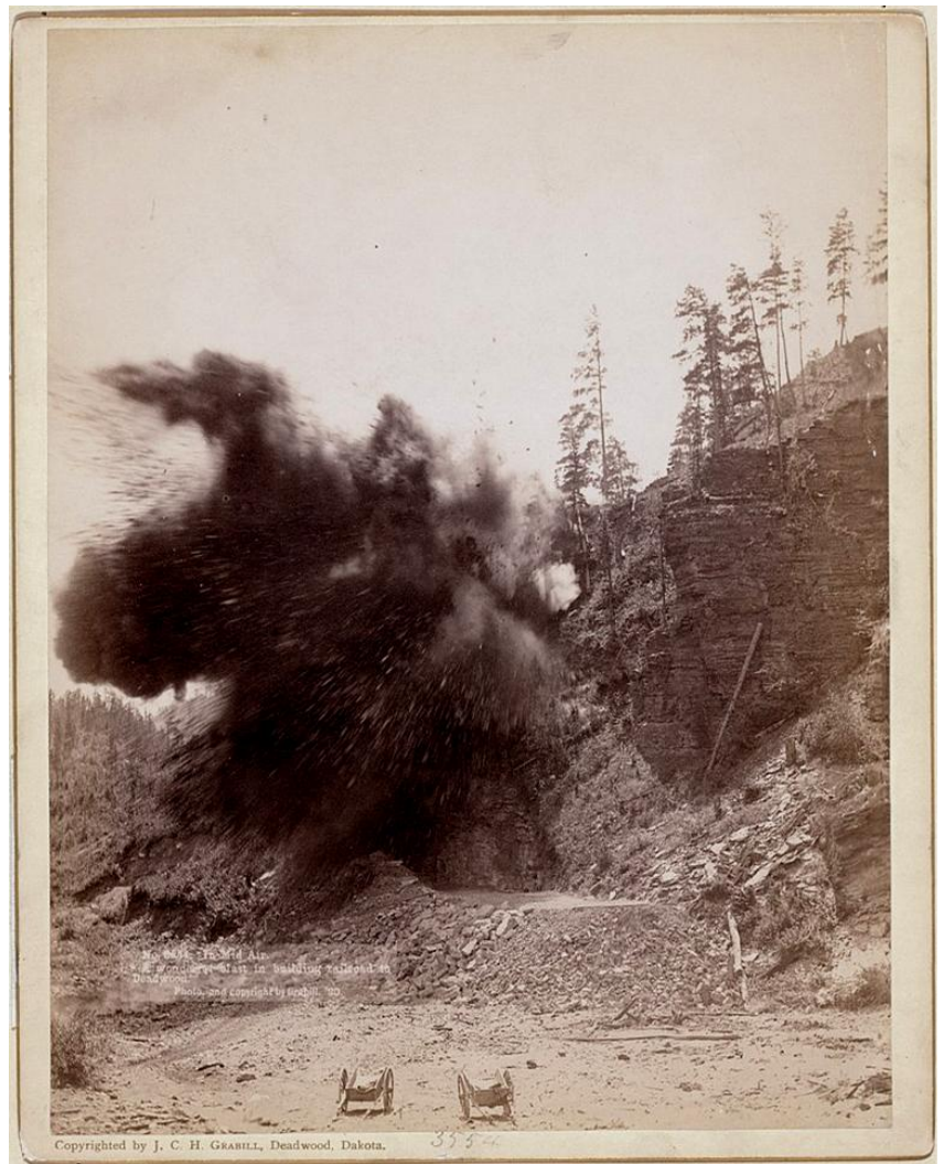
Felssprengung für die Eisenbahntrasse bei Deadwood 1890
